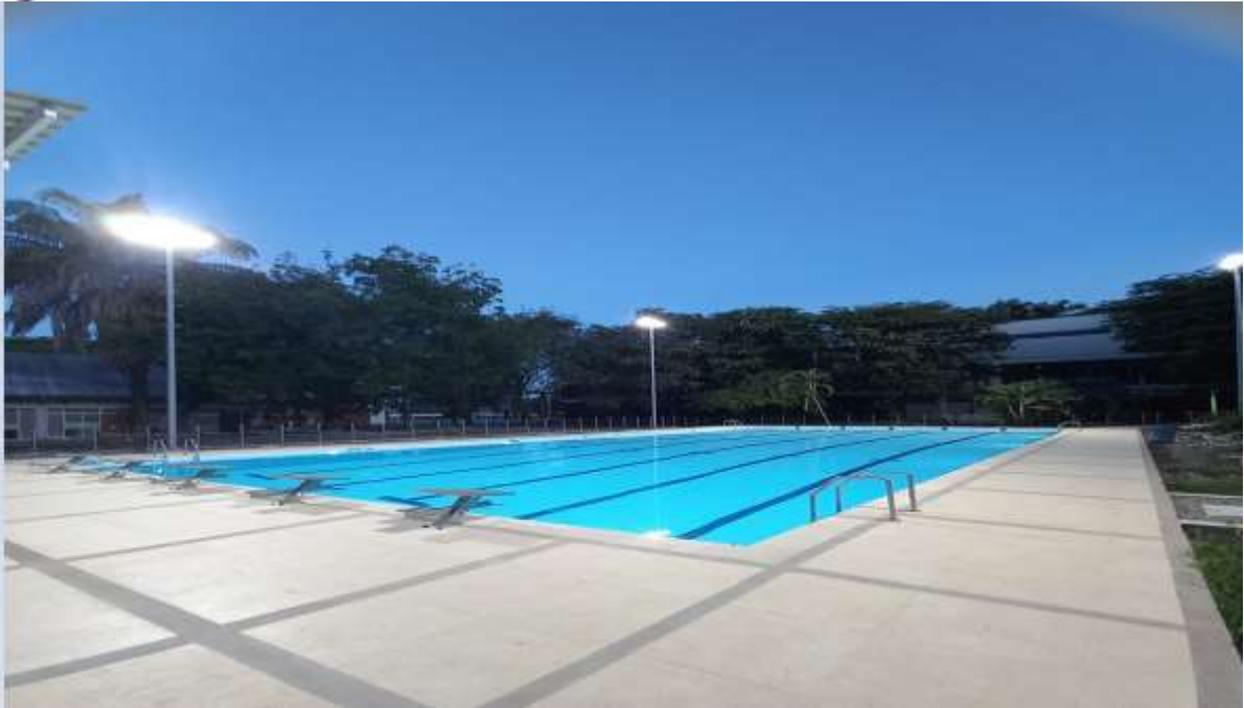
Foto: Sistema de iluminación de la Piscina del ITFIP con cuatro postes con tres lámparas led.
