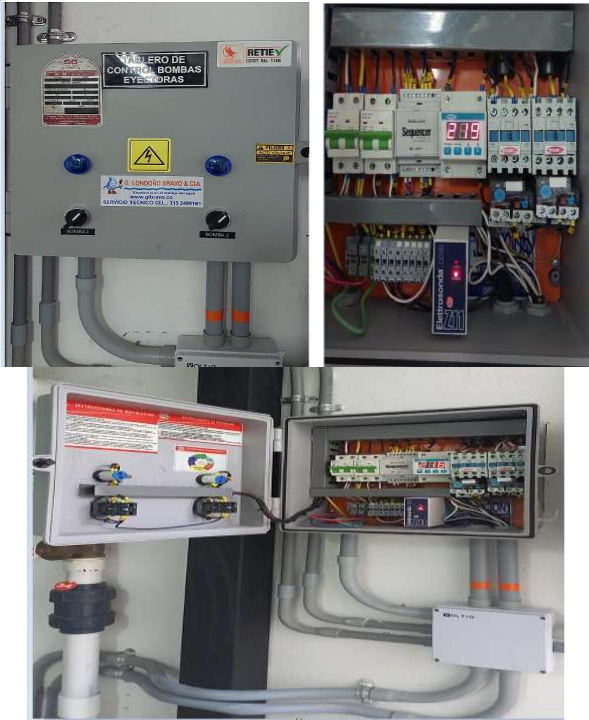
Foto: Tablero de control Bombas eyectoras de la piscina del ITFIP
