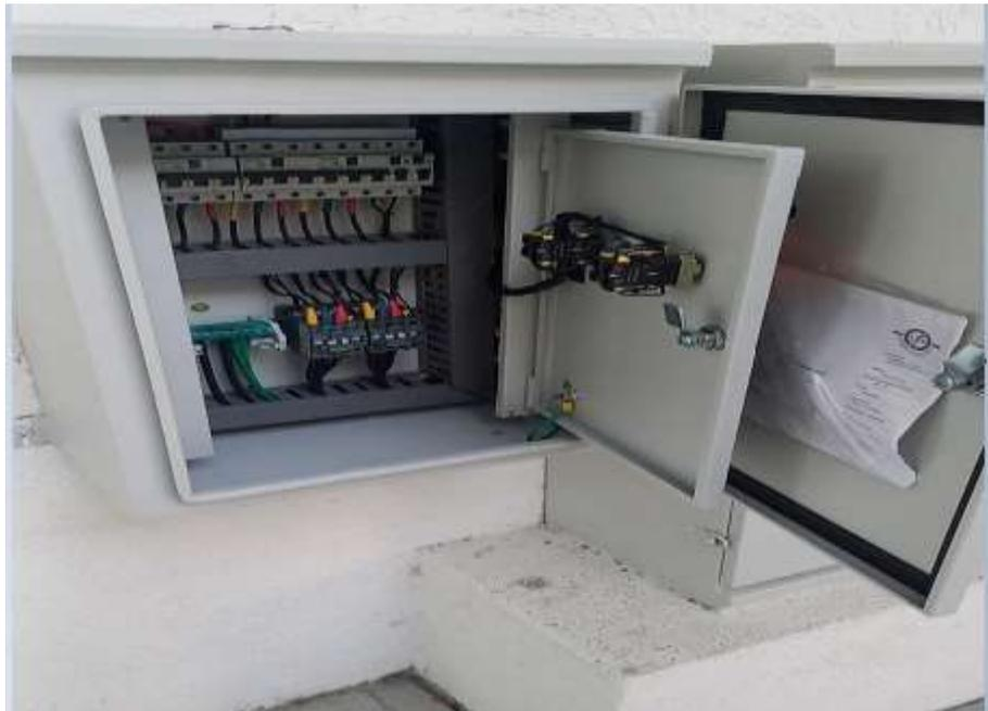
Foto: Tablero de circuito alumbrado exterior piscina del ITFIP
