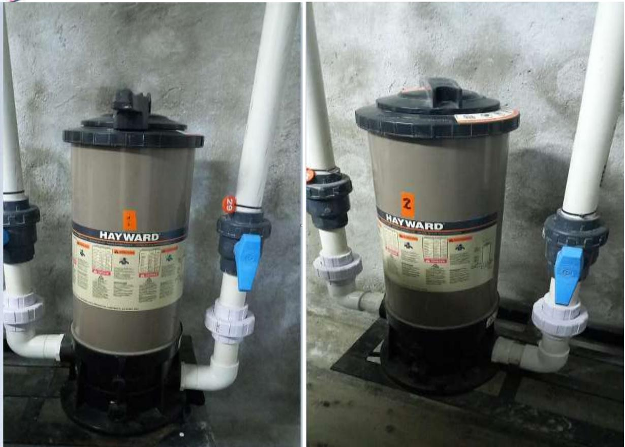
Foto: Alimentadores automáticos de Cloro de la piscina del ITFIP
