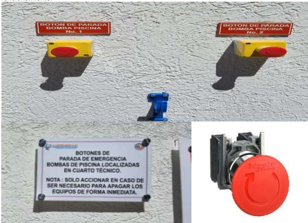
Foto: Botones de Parada de Emergencia y aviso de uso del ITFIP
