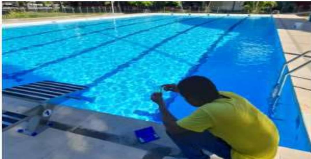
Foto: Mantenimiento Piscina del ITFIP – Toma PH
